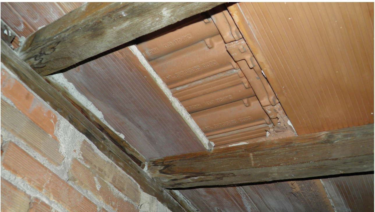
Particolare della stratigrafia di copertura (Travi, arcarecci, tavelloni, tegole marsigliesi)
